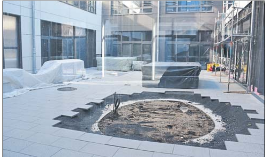
Das Rondell im Innenhof soll noch begrünt werden.
