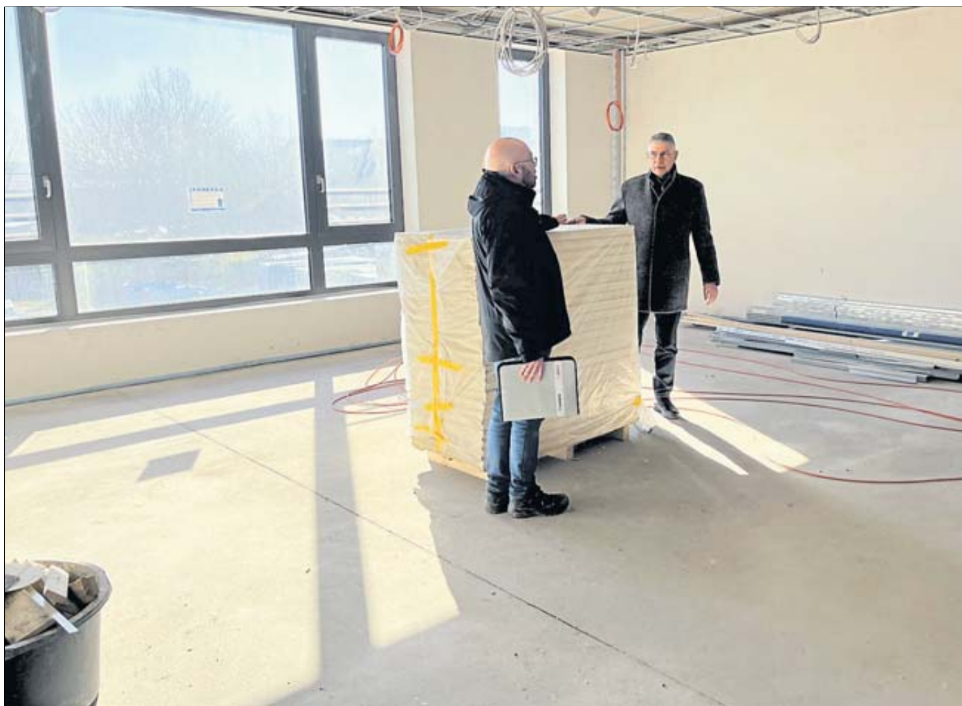
Landrat Manfred Görig (rechts) und Stefan Schmidt schauten sich bei der Besichtigung der Baustelle auch ein künftiges Klassenzimmer an. Foto: Jennifer Sippel/Vogelsbergkreis
